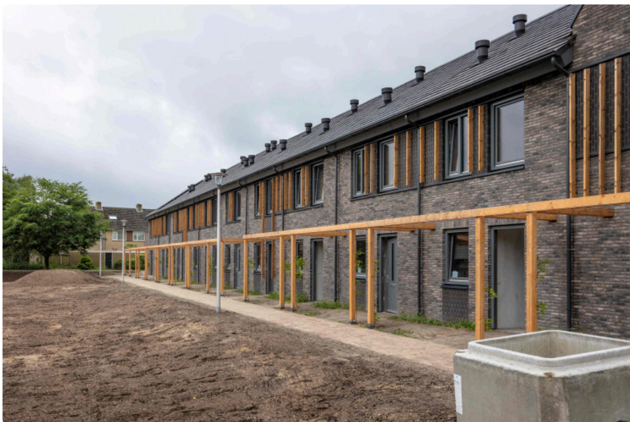
Project De Kaswachters, Zuidbroek Apeldoorn
