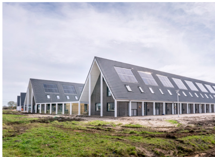
■ Nieuwbouw 68 huurwoningen Korrelhoed Apeldoorn
