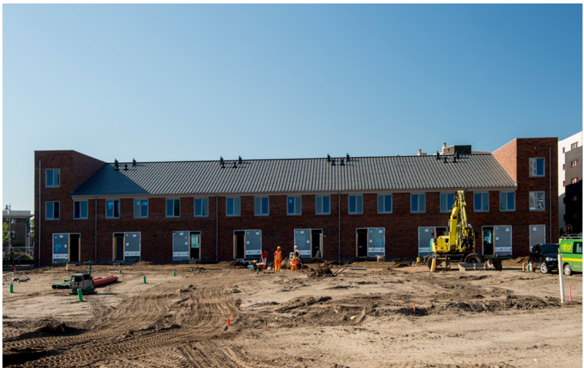
■ Nieuwbouw sociale huurwoningen Havenpark Apeldoorn
